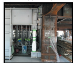
写真3 オイルダンパー施工状況写真
