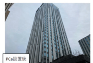
写真2 PCa設置後北西側外観
