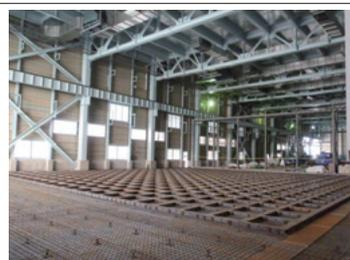
写真3 打込み定盤の土間施工状況
