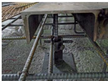
写真1 打込み定盤・土間配筋兼用スペーサー
