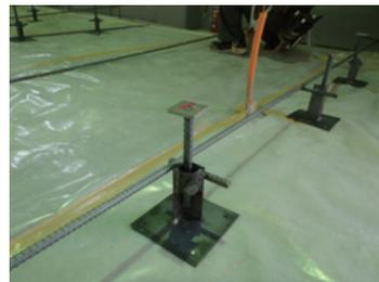
写真3 打込み定盤・土間配筋兼用スペーサー
