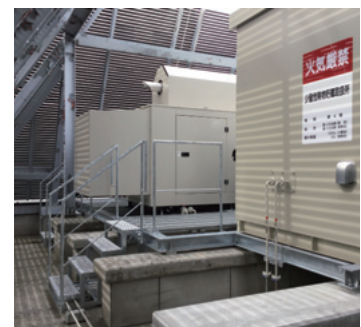
屋上 機器設置後
