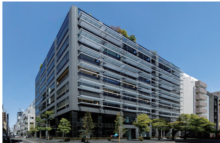
大成建設関西支店ZEBリニューアル 外観
