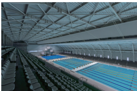
図3 内観写真(屋内水泳場)
