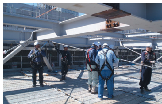
写真3 施工状況(PC鋼棒の張力計測)
