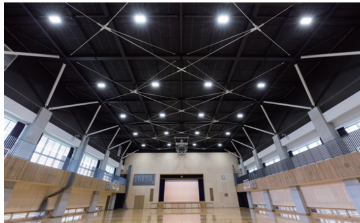
写真1 アリーナから見上げた新しい張弦梁
