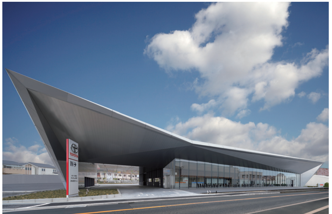
トヨタカローラ南海堺大野芝店 東側外観 外装材を全てアルミ材に統一することで、一枚の紙から折られた折紙のような形態を表現
