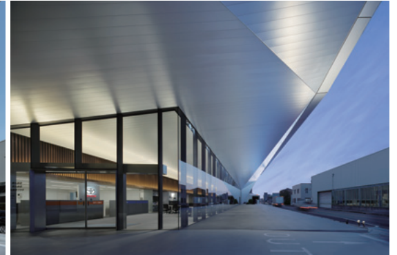
屋外展示場(夜景) 設備機器が現れない紙のような天井面
