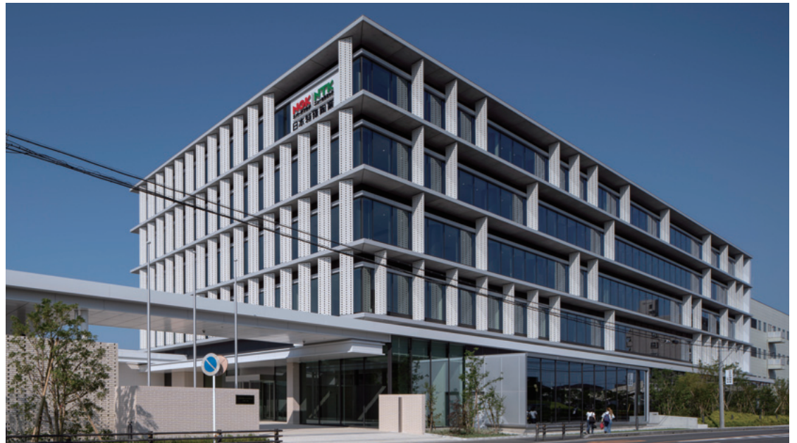
セラミックスを透かし積みにしたルーバーを採用した特徴的な外観
