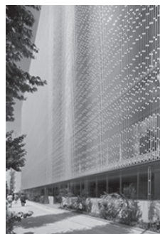
1階からの外観
