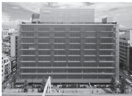
建物南側外観
