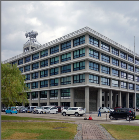
島根県庁舎 (安田臣設計/1959年)
