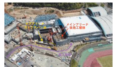
図5 サブアリーナ建方時現場状況
