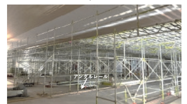
図7 移動式足場での天井仕上工事状況
