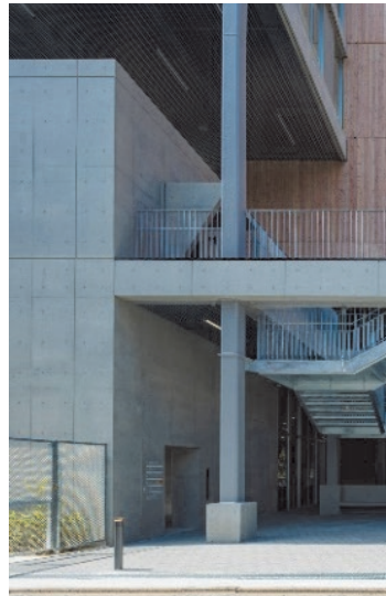
打ち放しコンクリート出来形
