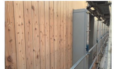
カラマツ仕上げ出来形
