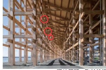
現地照明 取付状況
