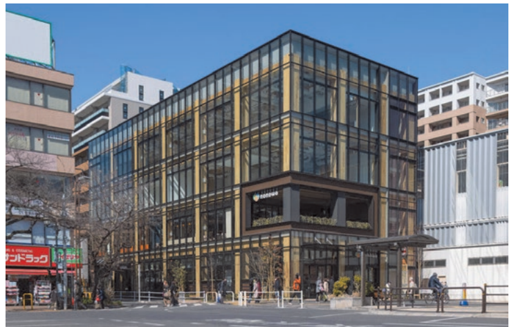
外観(南東より)
