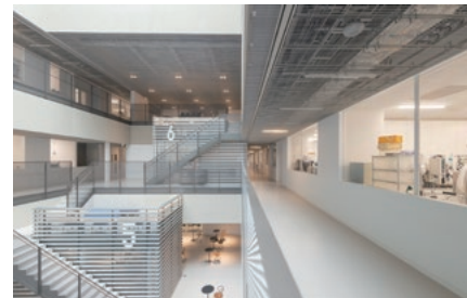
写真2-2 吹抜け部と廊下メッシュ天井
