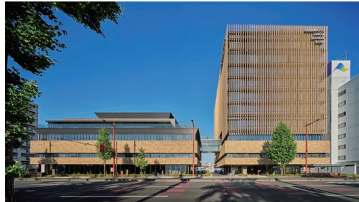
写真1 西より外観全景 写真:鈴木文人
