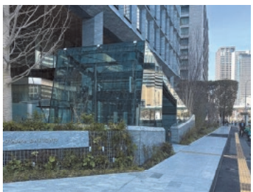
▲地下鉄出入口屋根架構
