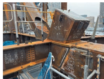
▲乗り換えトラス仕口
