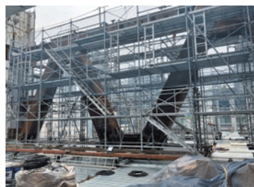
▲乗り換えトラス建方時
