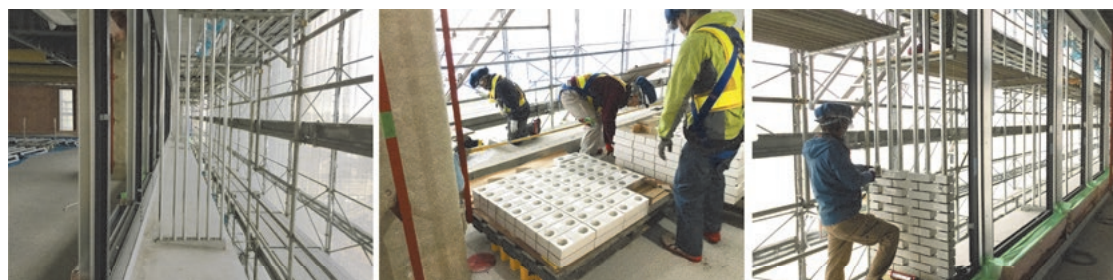
写真4 PC底施工後のルーバー取り付け状況
