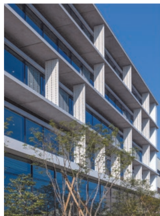
写真3 軒裏 RC素地仕上げの底
