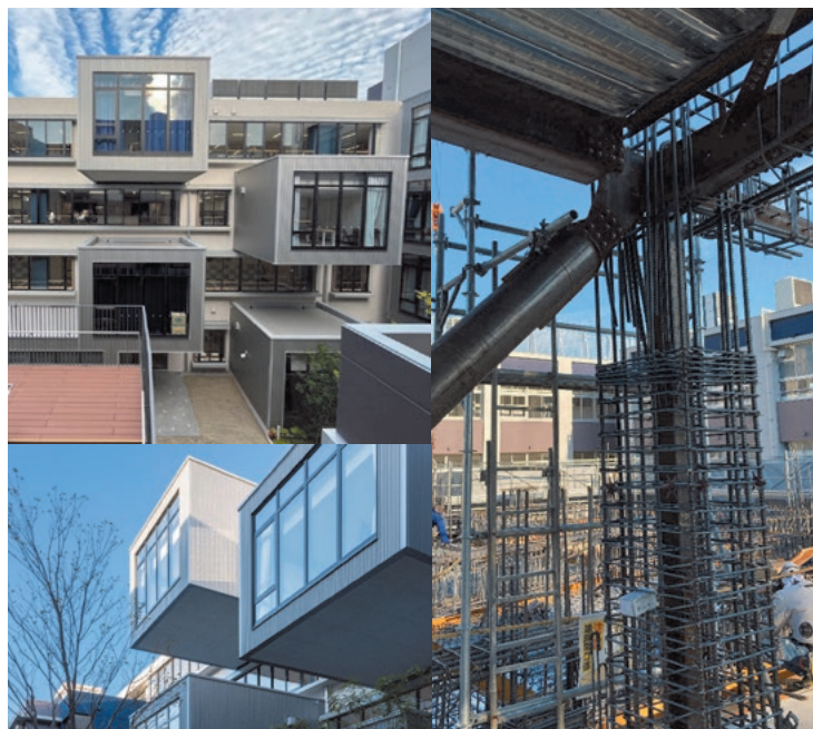
②張り出し鉄骨
