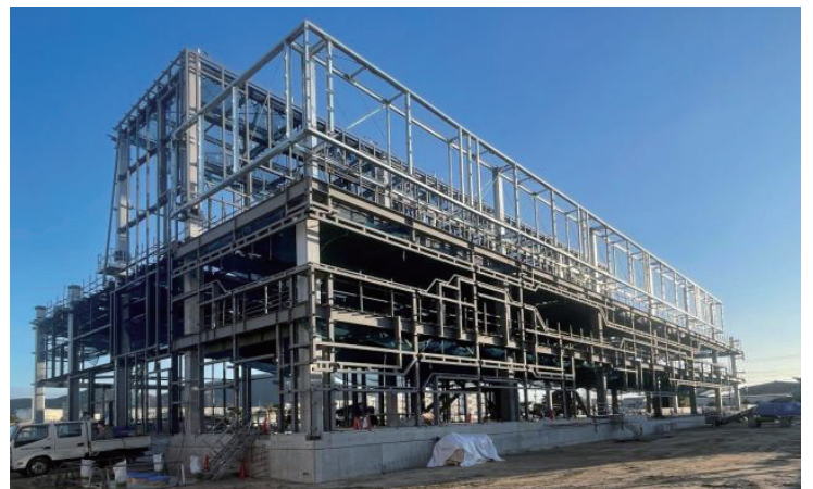
図3 外壁ECPの下地鉄骨
