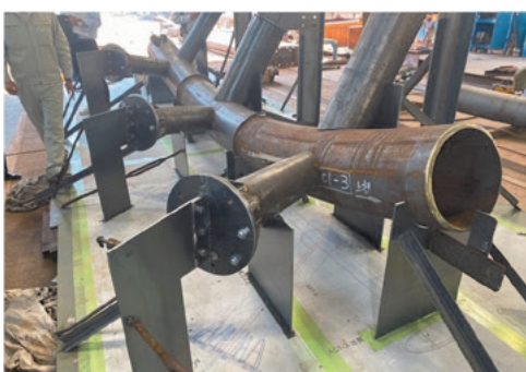
写真3 組立材の製作状況
