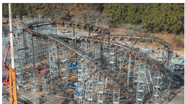
写真4 全部材の仮組み
