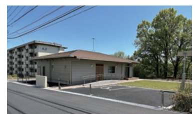
大分県営明野住宅建替事業
