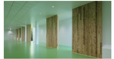
地場産木材で作られたCLT耐震壁
