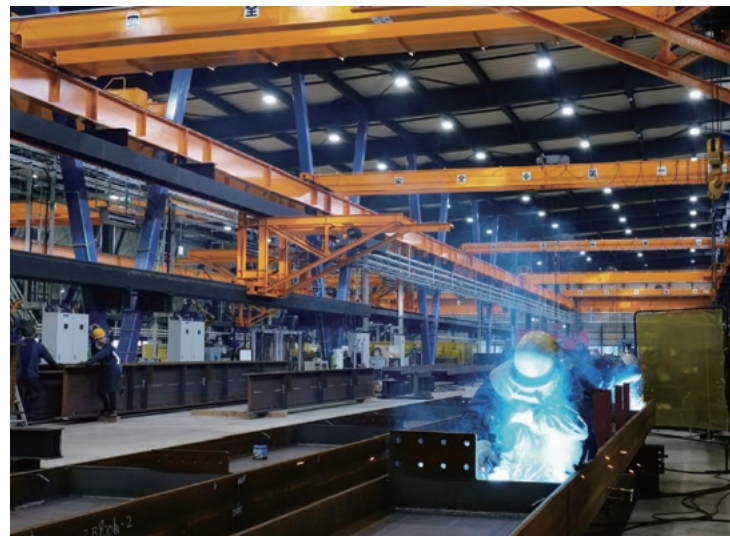
今までの鉄骨加工工場を一新する、社員自らが作り上げた、魅せる鉄骨ファブ工場
