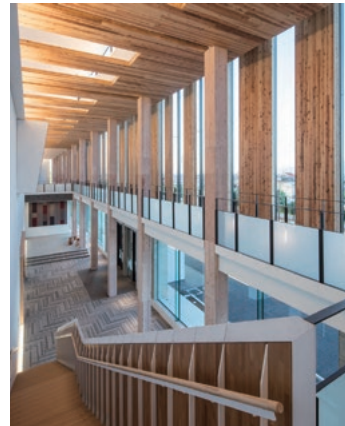
206立米の秩父杉を活用したエントランス
