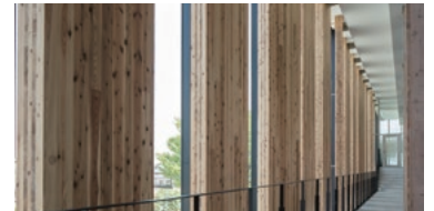
風荷重を支持する「CLTバックマリオン」
