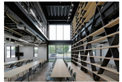
食堂吹抜けに面した耐震棚
