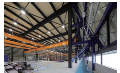
組立柱が林立する安全通路
