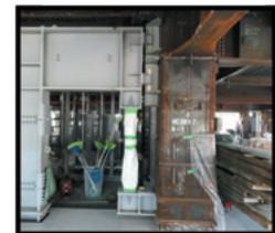
写真3 オイルダンパー施工状況写真
