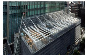
写真3 鉄骨塗装用足場組換
