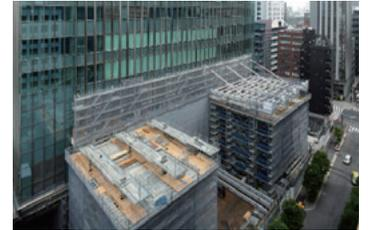
写真2 鉄骨用足場架設
