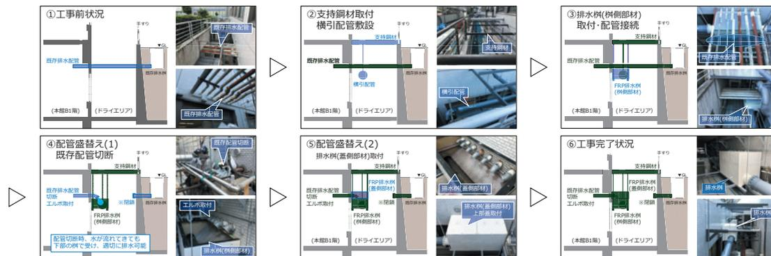
図3 FRP排水二分割柵を活用した不断水での排水配管盛替え手順
