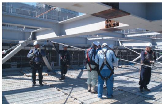
写真3 施工状況(PC鋼棒の張力計測)
