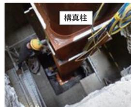
写真2 地下柱施工状況(他事例)
