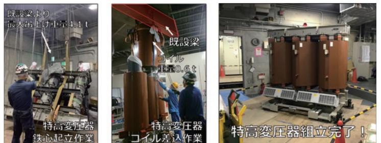
写真 特高変圧器の電気室内現地組立状況
