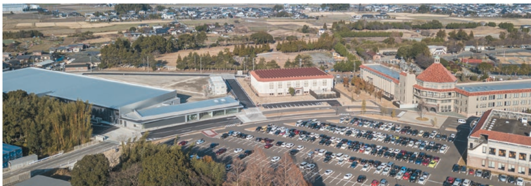
キャンパス全景：本館（写真右）竣工後、駐車場・外構工事を実施。2021年 新工場 Tech Forest 完成（写真左）
