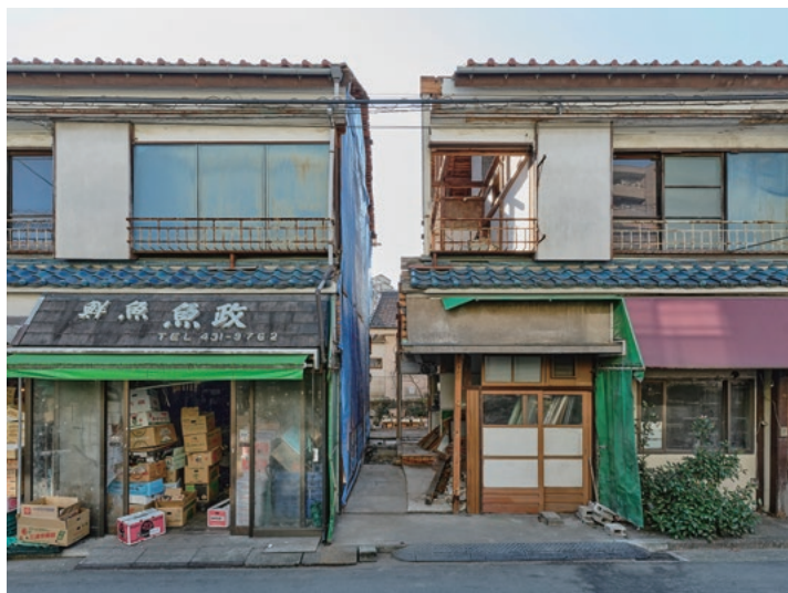
写真1 既存建物の切断時
