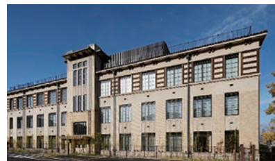
図3 改修後の東側外観*
