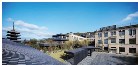
図4 改修後のエントランス部からの眺め*
