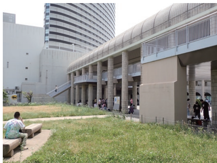
図11 空地となった商業施設
