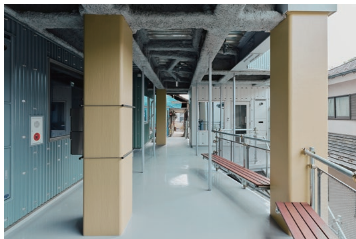
写真7 新築棟2階共用部
