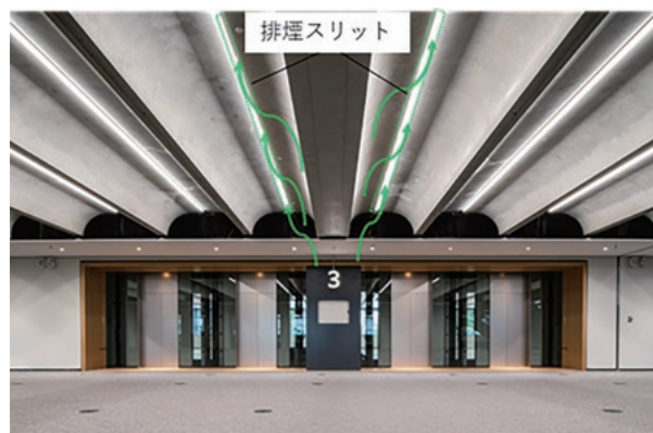
PCスラブ排煙スリット
