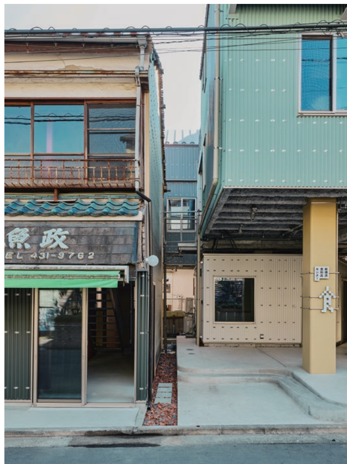
写真4 新築棟と改修棟の隙間
