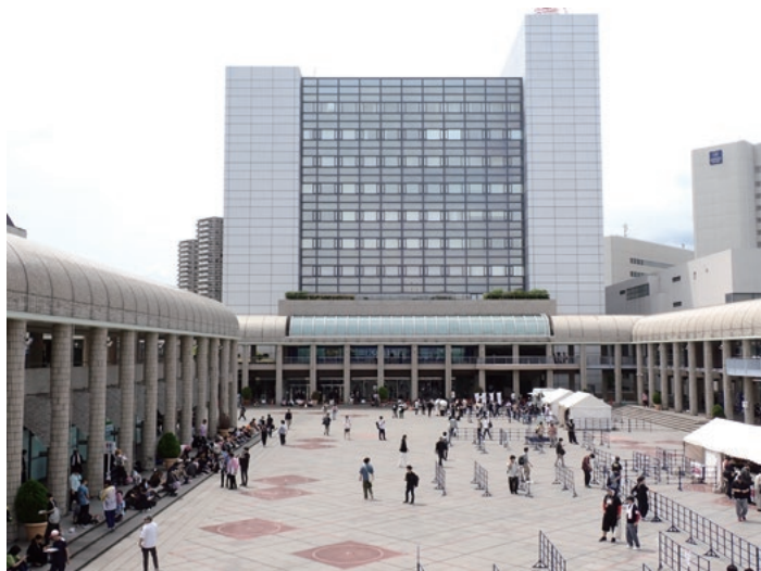
図5 国際交流会館と市民広場の現況
