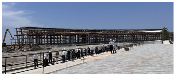
大屋根リング解体は水上ショーの観客席から見学
