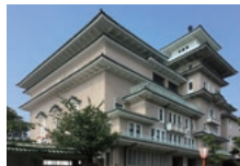
増改築前 南西側全景
