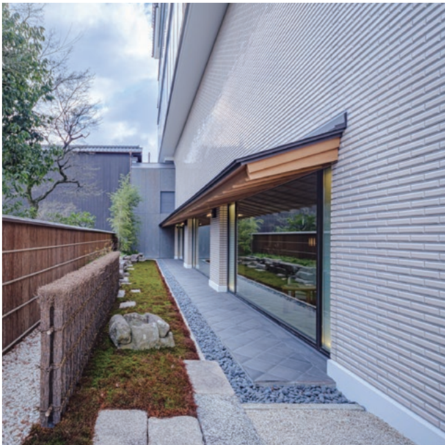
再構築された北側外壁面は現代の乾式製法タイルを採用
