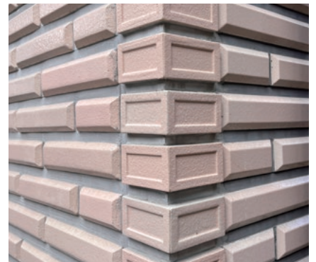
南東コーナーで湿式タイルと乾式タイルが切り替わる
