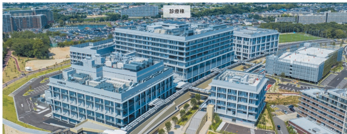
写真1 プロジェクト全体外観
