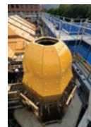
型枠建込状況-1
