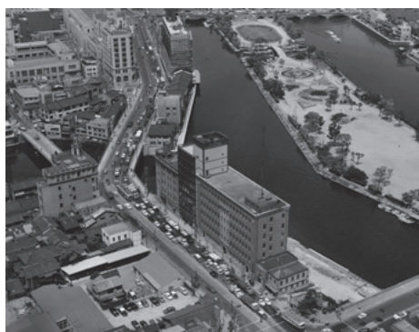
竣工時南東面鳥瞰
