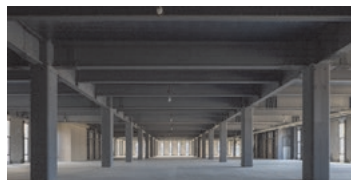
写真2 スケルトン状態
