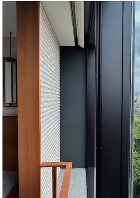
北と東の外壁は元の壁位置でタイル壁を再現
