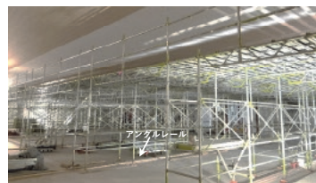
図7 移動式足場で天井仕上工事状況
