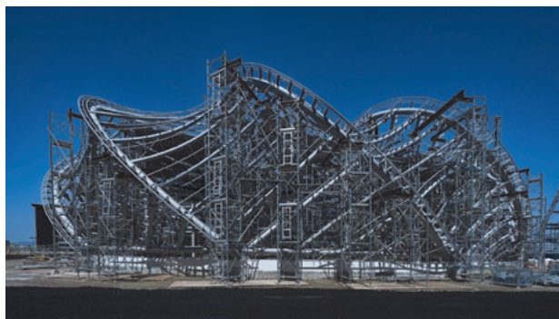
写真2 「斜めアーチ千本格子」の鉄骨建方 (写真：木田勝久/FOTOTECA)
