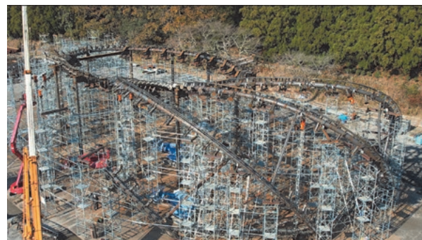
写真4 全部材の仮組み
