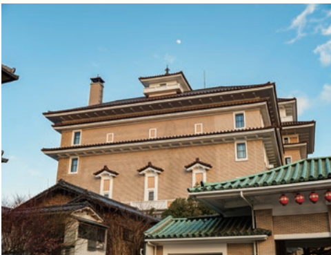
花見小路に面する西面の大半は既存タイルを存置
