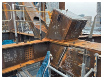
▲乗り換えトラス仕口
