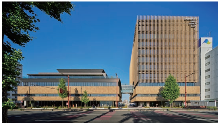
写真1 西より外観全景
