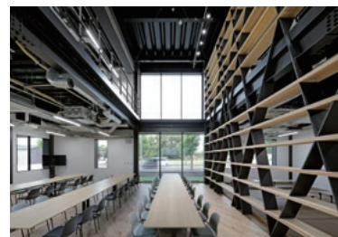
食堂吹抜けに面した耐震棚
