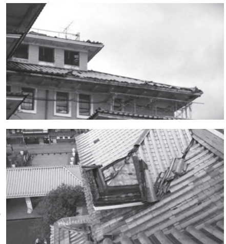
一部飛散し老朽化した屋根 (施工前の状況)
