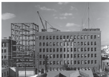
鉄骨建方工事（南面）
