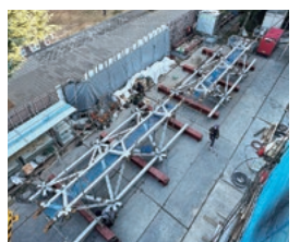
【トラス鉄骨地組状況】
