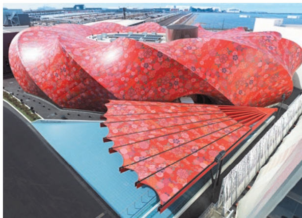
写真1 全景 大屋根リング上空より
