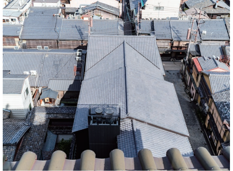
北棟を本棟バルコニーより臨む
