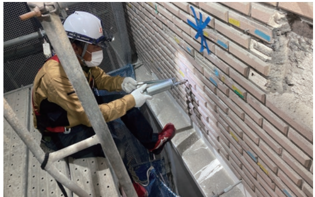
ピンディングの作業状況
