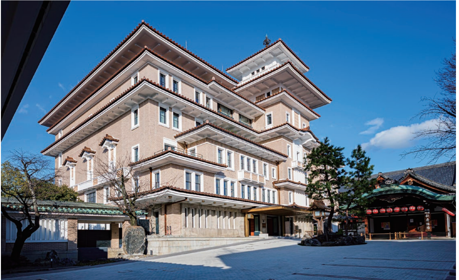
西面の過半と南正面タワー部のタイルはオリジナルのタイルをピンニングにより存置。5階西南面コーナーからタワーまでとタワーから東側を湿式タイルを採用。
