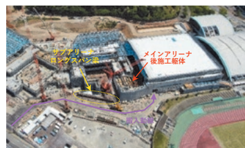
図5 サブアリーナ建方時現場状況
