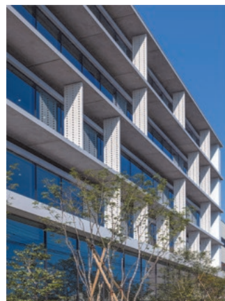
写真3 軒裏 RC素地仕上げの底
