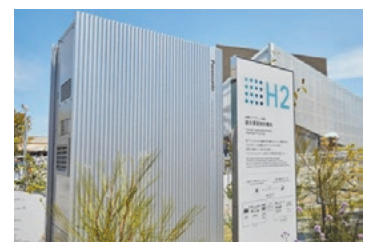
写真3 純水素型燃料電池
