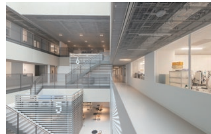
写真2-2 吹抜け部と廊下メッシュ天井
