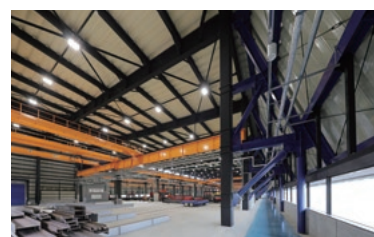
組立柱が林立する安全通路
