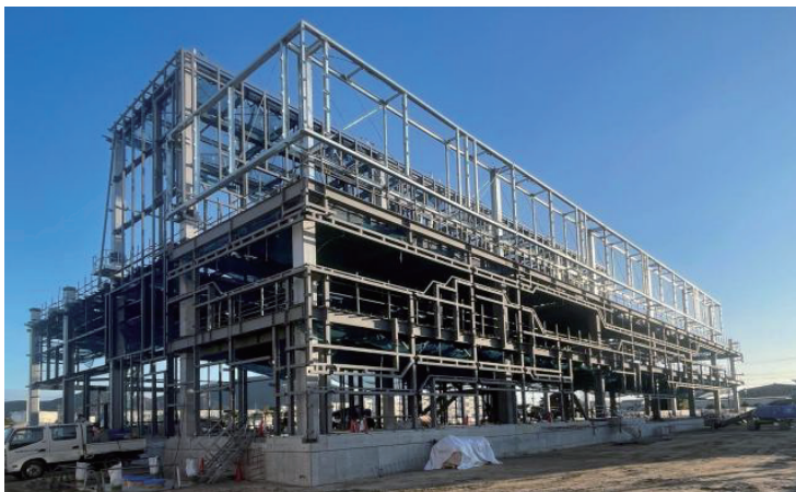
図3 外壁ECPの下地鉄骨
