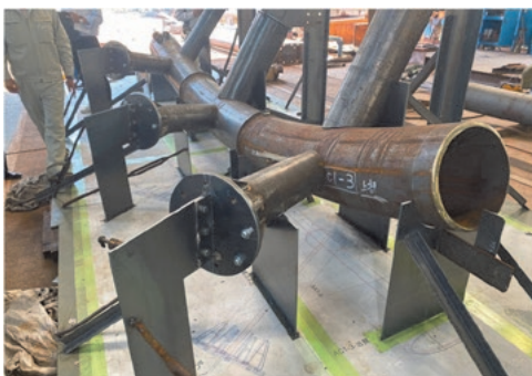
写真3 組立材の製作状況
