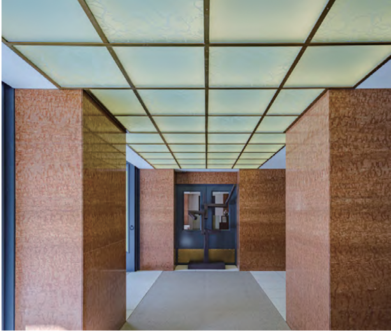
1階風除室ガラス天井 飛散防止加工の上、再設置（一部復原）
