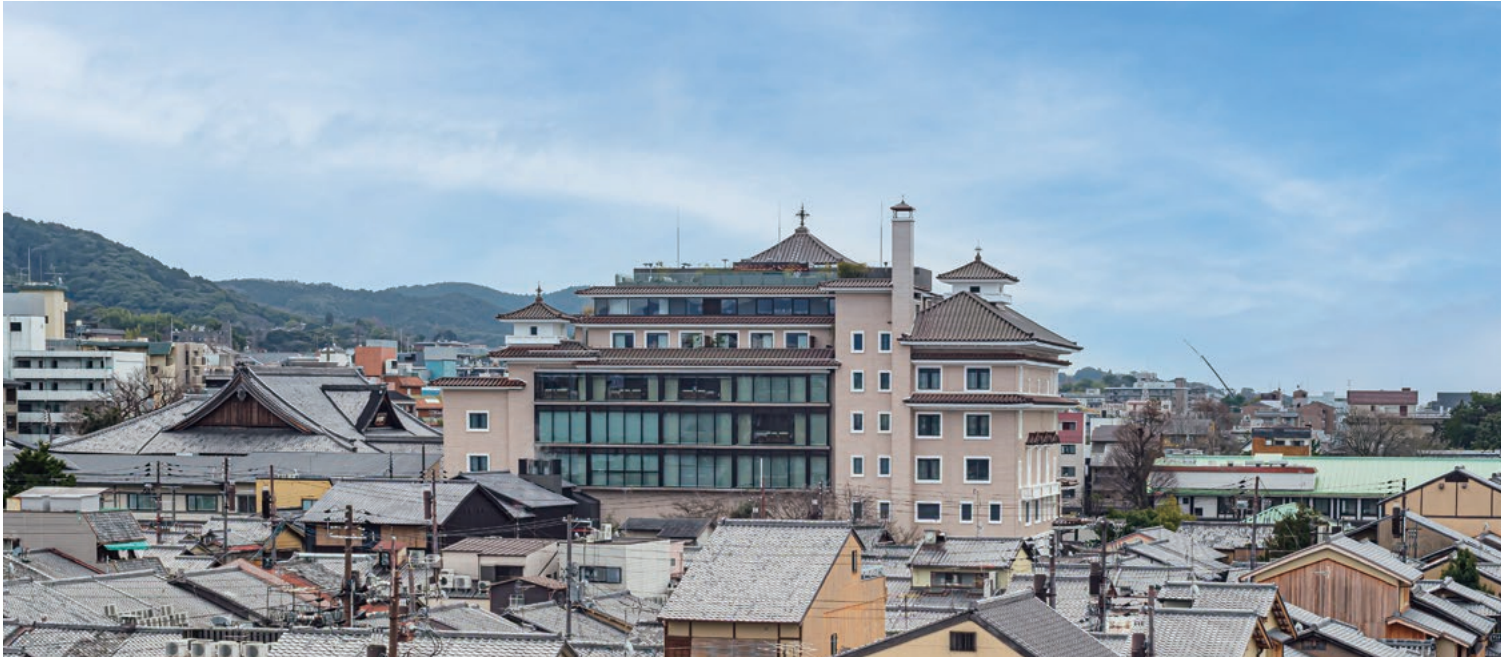
北面からの眺め。西面はオリジナルタイル、北面はガラスカーテンウォールの内部を含めて現代の乾式製法タイル。
