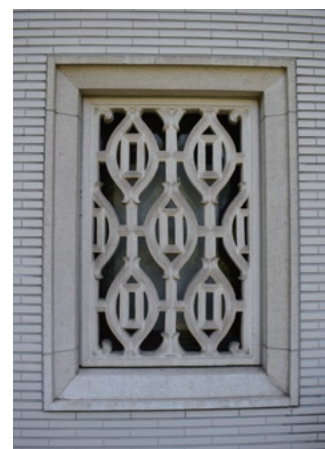
写真14 写真3 中央の北面の小窓、飾り格子は「人造石透明及浮影ブロック小叩き」仕上げ**
