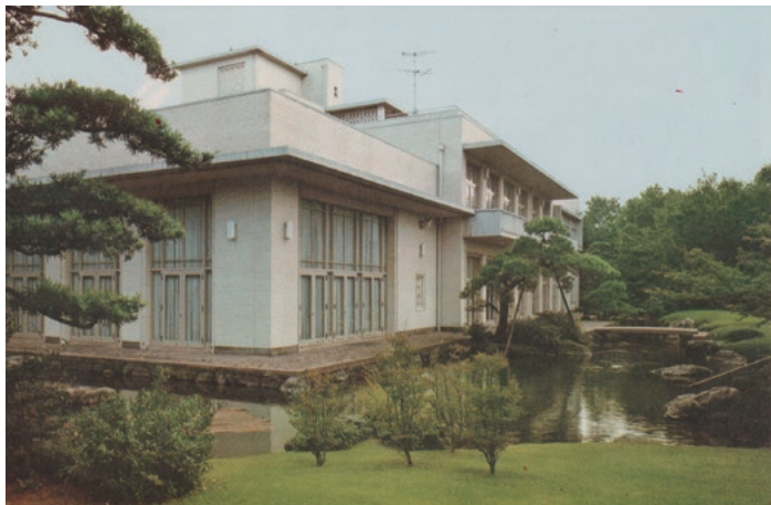
写真3 竣工頃の北東面外観*
