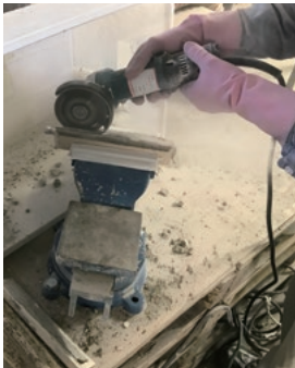
付着しているモルタルを除去
