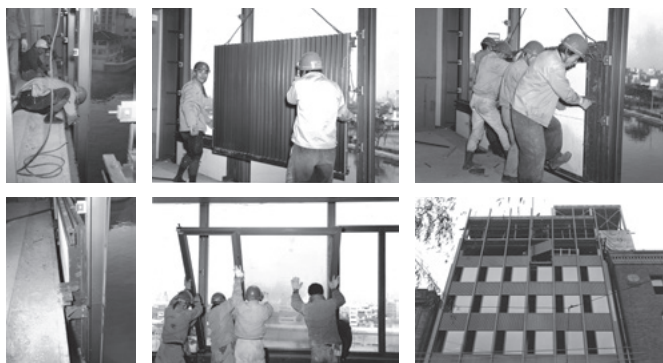
当時のアルミカーテンウォール取付作業
