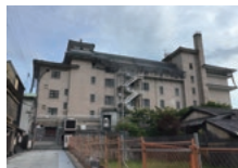
増改築前 北側全景
