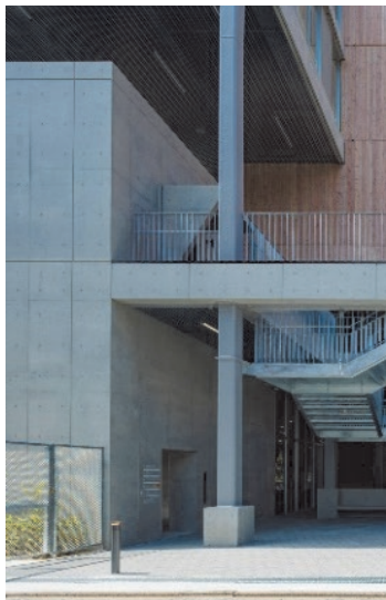
打ち放しコンクリート出来形
