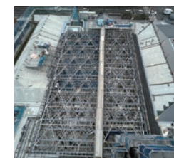
【中央書庫トラス鉄骨建方完了】
