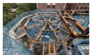
【エントランス棟 鉄骨建方状況】
