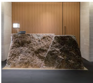
B1階カウンター_万成石、勝連トラパーチン
