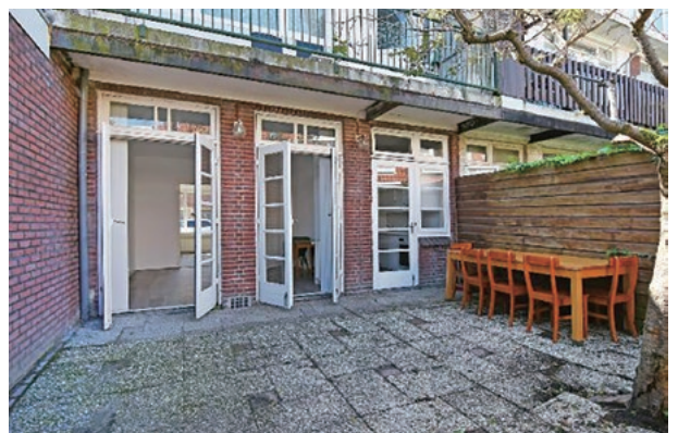
図6 バックガーデン外観
