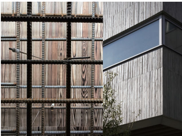
焼杉型枠打設前と仕上がり ※右
