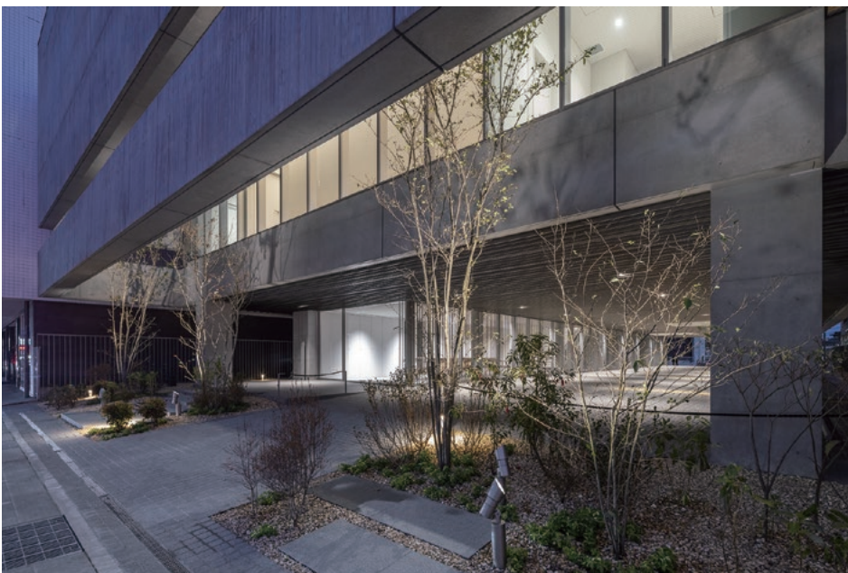
まちとの接点に外壁を3.6m跳ね出した緩衝空間*
