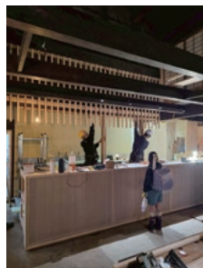
厨房にルーバーの設置
