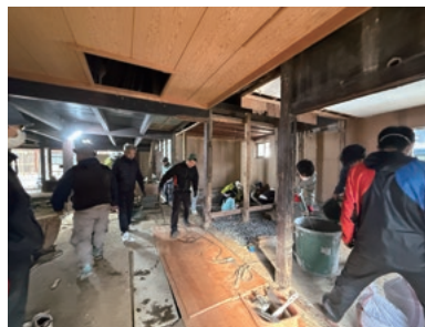
受講生によるモルタル土間打ち
