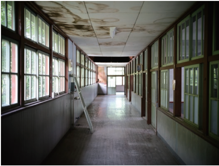
図4 旧十津川村折立中学校 廊下
