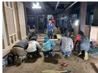
並んで手拍子と共に三和土施工
