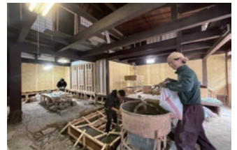
エントランスに大きな囲炉裏を制作
