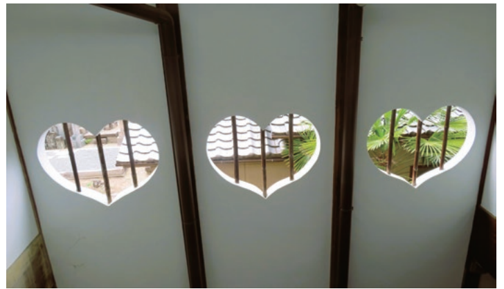
写真10 人気がある3連のハート型窓。実は台所の煙出し。
