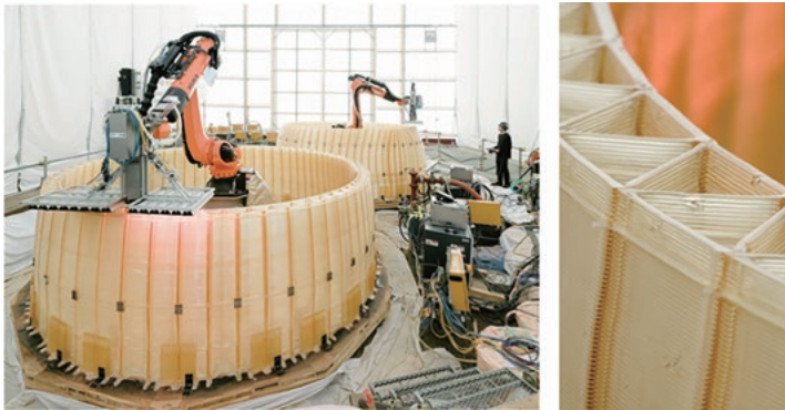
図4 3Dプリンターによる施工状況写真
