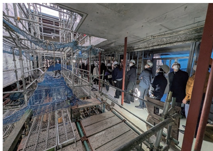
足場が組まれた施工途中の現場を見学
