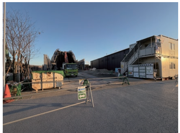
解体工事が進むハンガリーパビリオン
