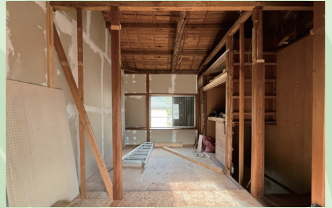
図1 改修中の長屋の様子
