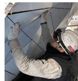
1枚毎調整し貼り付け、隙間が合致しないものは再製作 設計：(株) 畑友洋建築設計事務所
