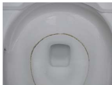
図1 便器の輪じみ汚れ
