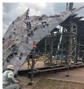
1枚毎調整し貼り付け、隙間が合致しないものは再製作 設計：(株) 畑友洋建築設計事務所
