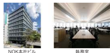
図7 NOK本社ビル
