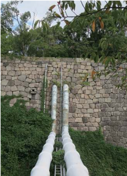
堀を横切って石垣を貫く水道管。明治期に造られ今も現役
