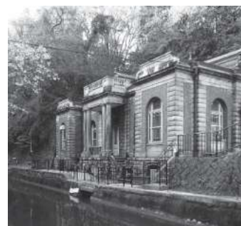
旧御所水道ポンプ室 画像提供：京都市上下水道局
