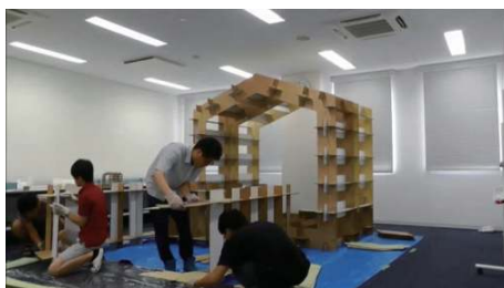
写真3 学生による仮設空間の組立状況
