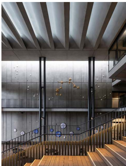
図4 すっきりと納めた細径鉄骨柱の柱頭 (撮影：株式会社プライズ 山崎浩治)
