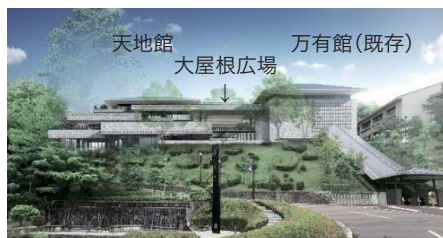
図1 段状テラスと大屋根の西面ファサード
