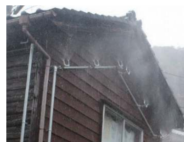
写真2 ドレンチャーによる外壁散水の様子
