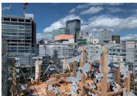
写真4 7階施工風景（一部の耐火被覆は現場施工）
