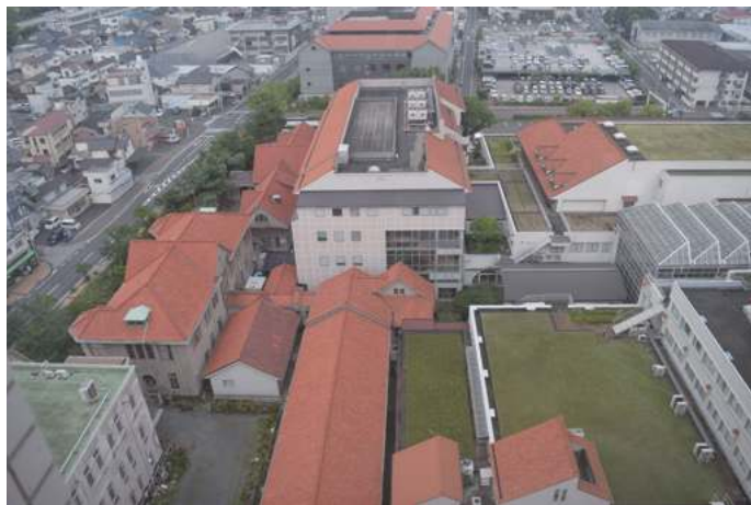
⑪新第3棟の屋上より、西南側を見る。
