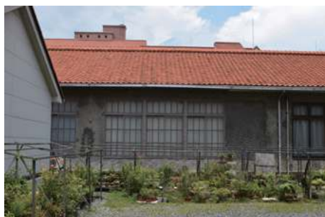
⑫旧第1病舎（現、臨床研究センター）南面
