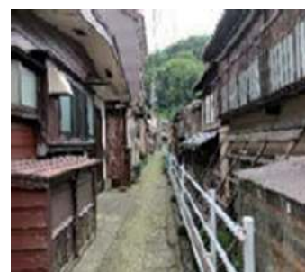
写真1 木造密集地区の狭小な側道
