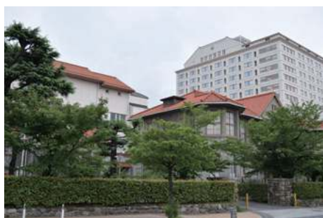
⑬敷地南に建つ旧入院玄関棟
