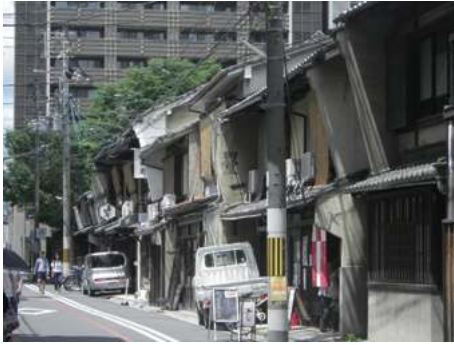
防火袖壁が連続するまちなみ（防火改修事例）
