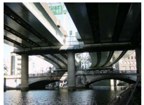
写真13 日本橋上空首都高速道路
