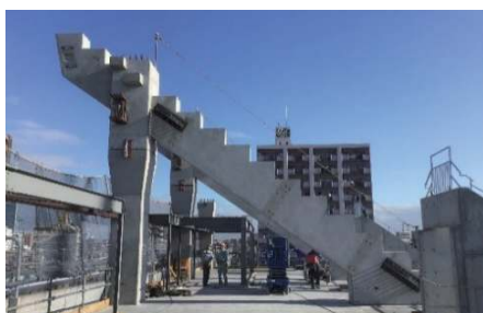
写真3 上部躯体工事状況
