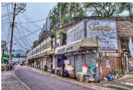
写真8 「トンネル横丁」市場
