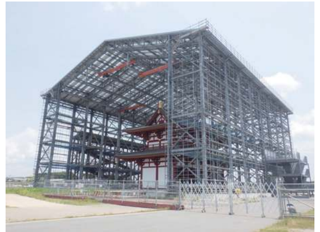
曳家工程前の南門・素屋根
