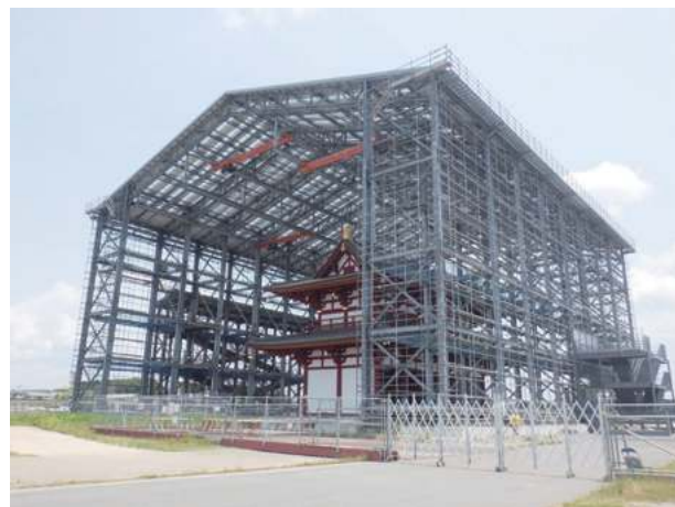
曳家工程前の南門・素屋根
