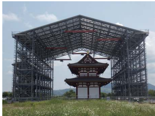
西側より曳家方向の東に向かって撮影
