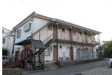
駅から徒歩20分の本賃アパートであるため、住戸改修ではなく、デイスサービスへの転用を選択した。
