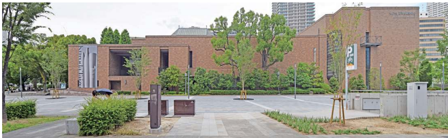
① 全景を南から見る。1982年竣工の本館は地下1階、地上2階。写真右側の3階建て部分が1997～98年に増築された新館である。
