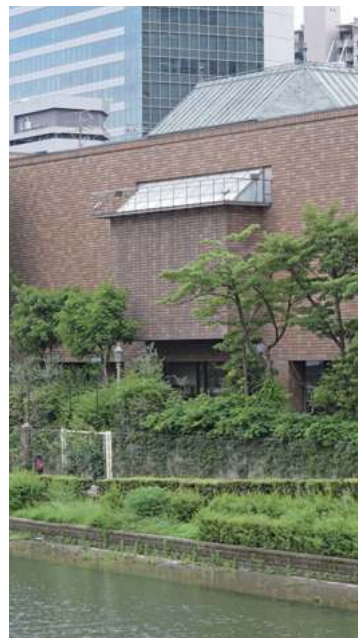
⑧ 自然採光室トップライトを北西から見る
