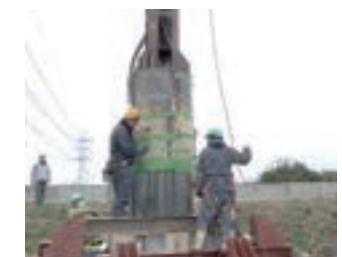
写真3 実大杭を用いた施工実験
