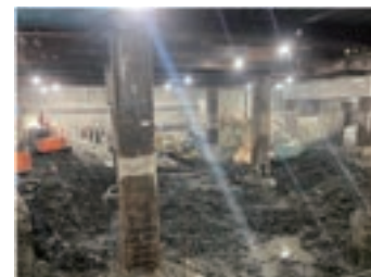
写真2 逆打ち工法による掘削
