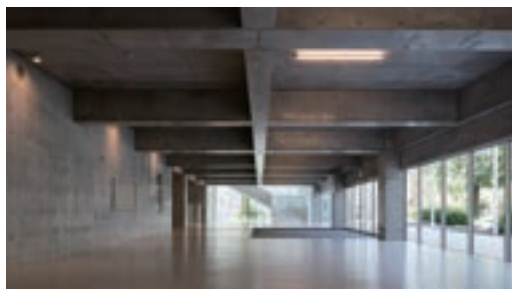
RC 打放しの下部構造
