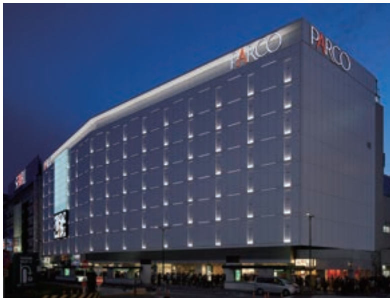
池袋パルコ外壁改修工事
