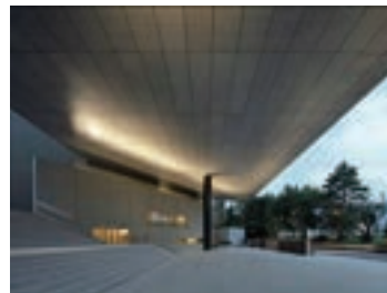
写真2 ピロティ部の見上げ
