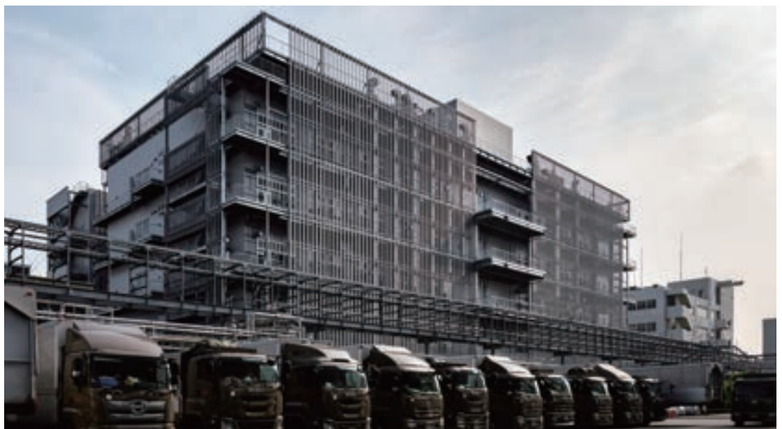
住友電工 伊丹製作所 研究新館
