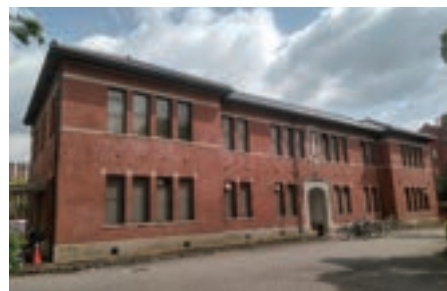
既存建物外観
