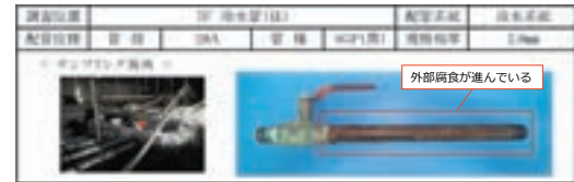
図1 冷水配管抜管調査
