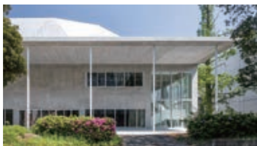
大庇及びピロティ
