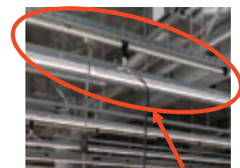
設備ラインと照明ライン 照明、設備ラインを取付けたオフィス天井
