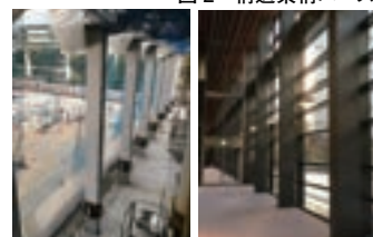
写真5 2階吹抜け部 2層またぎ長柱細柱の建方状況写真と竣工写真
