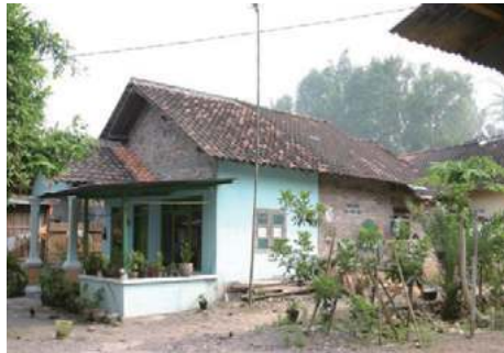
増築されたコアハウス
