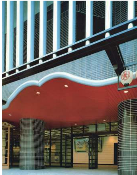
⑥唐破風を引用したエントランス （『建築と社会』1984年5月号）
