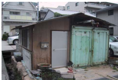
コンテナを利用した自力仮設住宅
