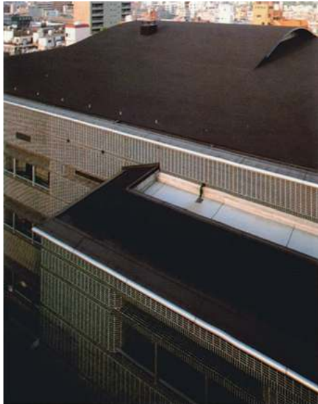
④劇場ホール部分に被さる中央の大屋根 （『建築と社会』1984年5月号）
