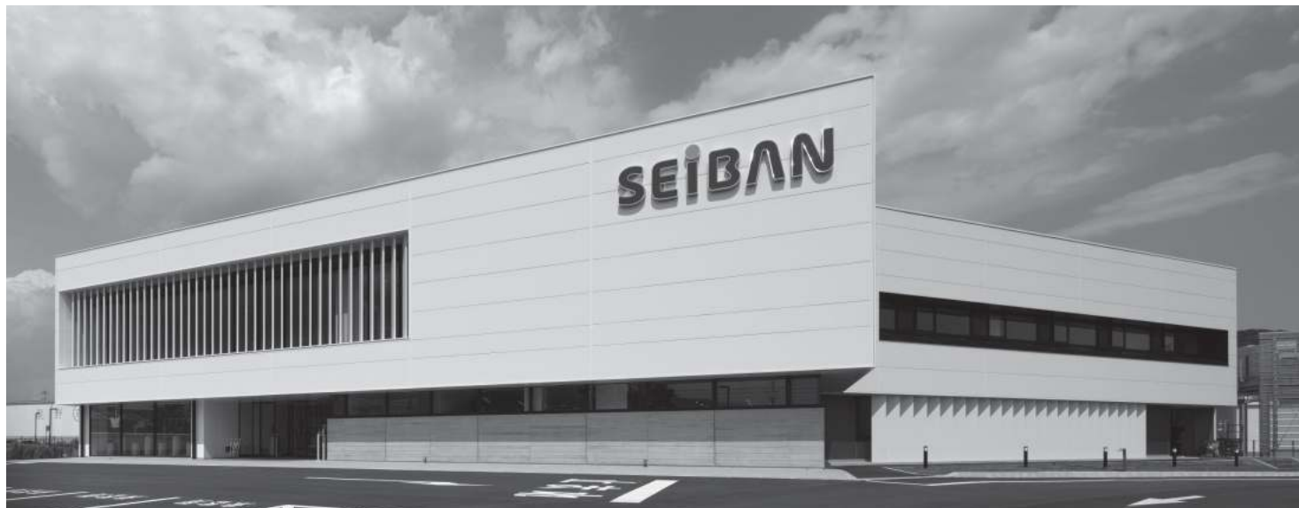
大きなウエルカムボードのような外観ファサード
