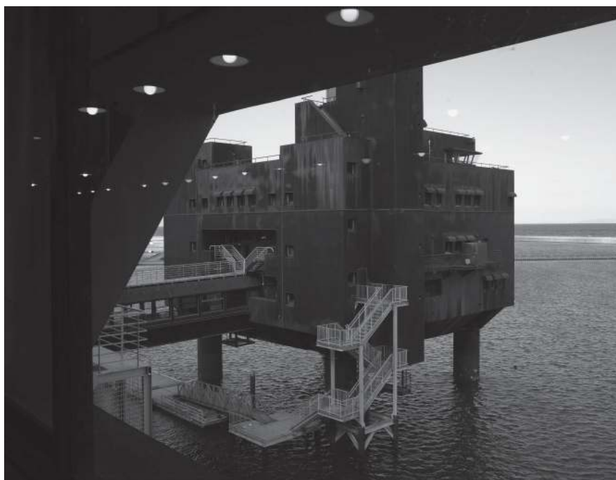
宿泊棟から研修棟を望む
