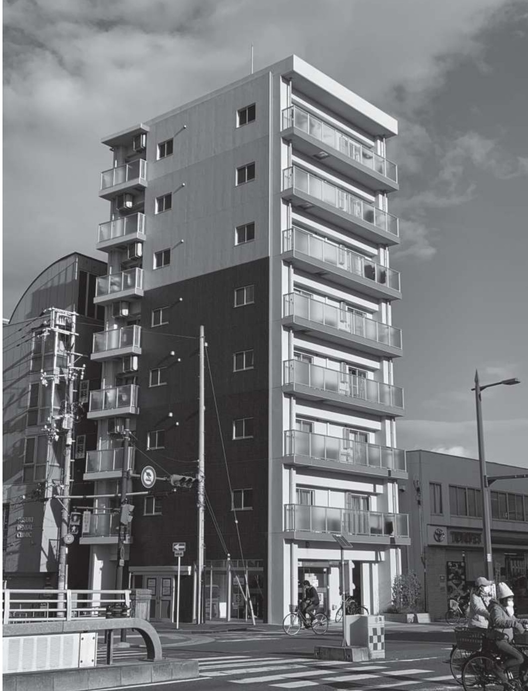
緑陰道路と国道に面する敷地
