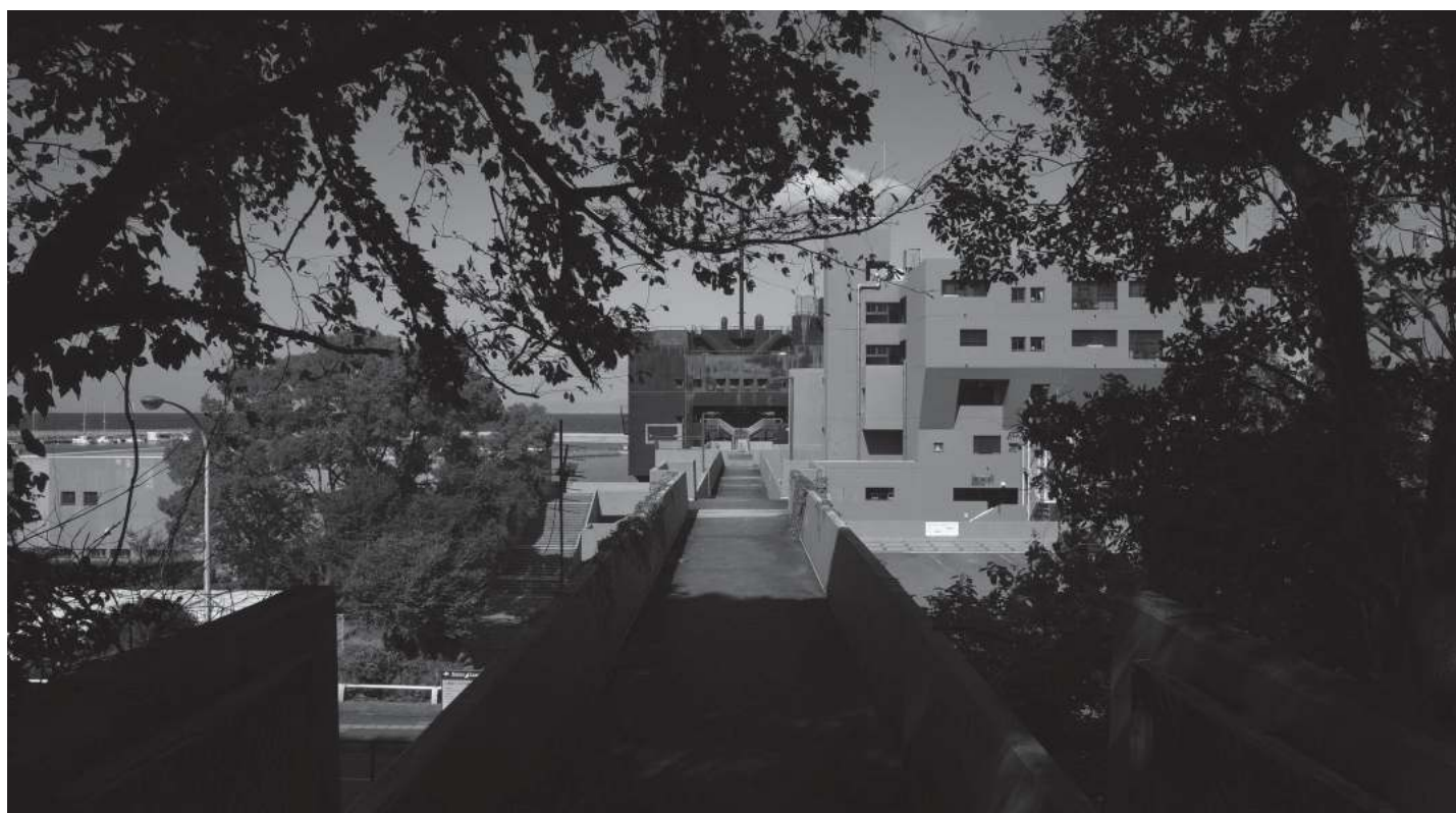
山側から延びるペデストリアンデッキの先に研修棟が見える。右側は宿泊棟
