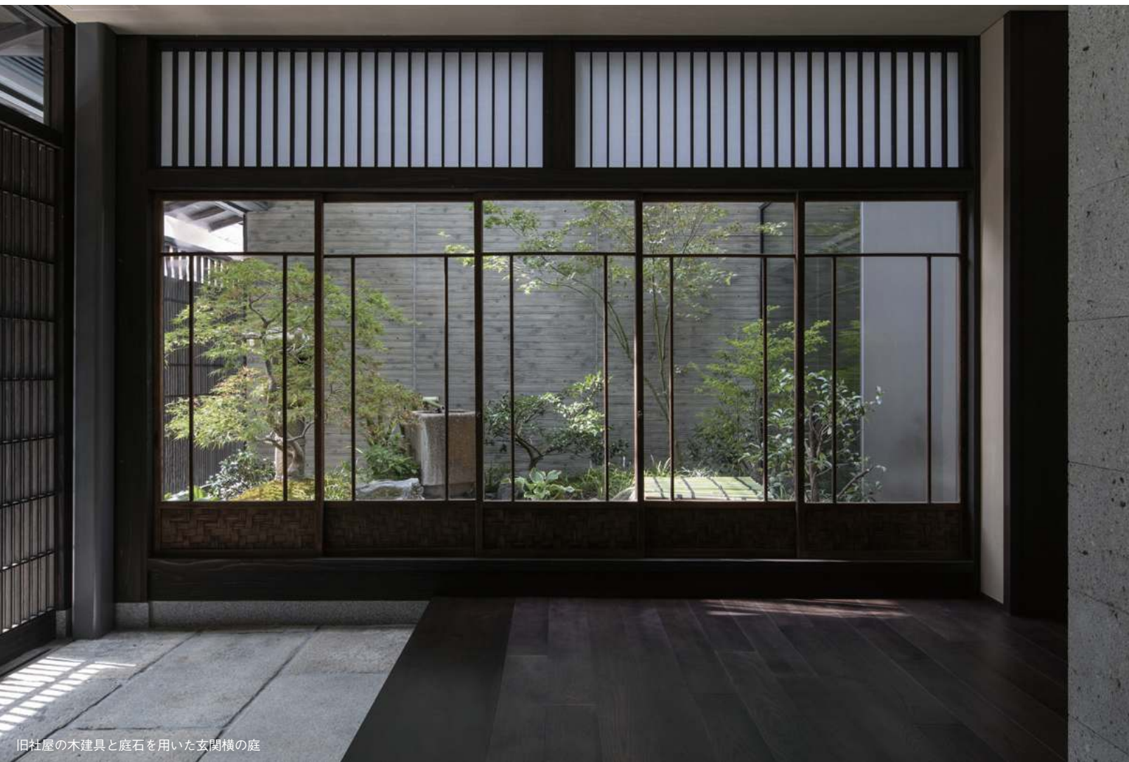
旧社屋を構成した木構造材を再利用した糸屋格子が通りの風景を形成する
