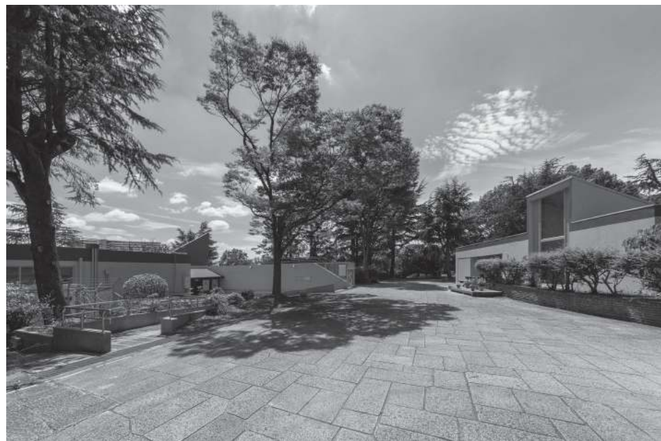
改修後の外観
