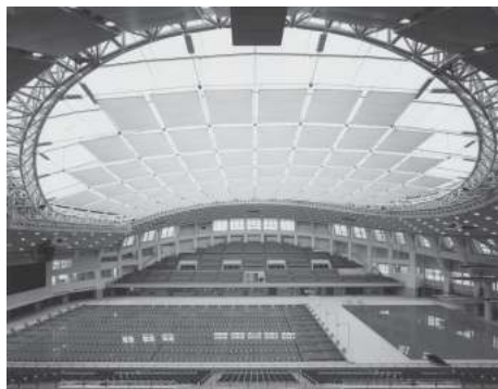
写真8 大阪プール内観
