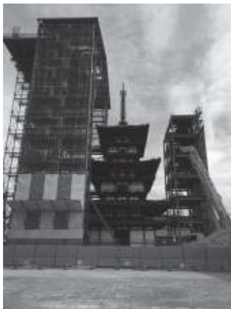
写真12 薬師寺東塔素屋根スライディング
