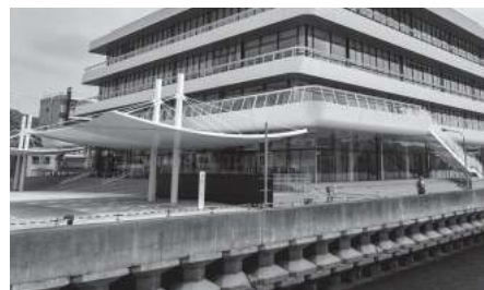
外装鋼板と鋼板底
