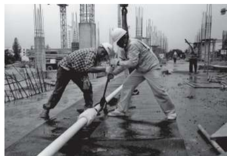
写真2 タイロッドの組み立て（'97撮影）
