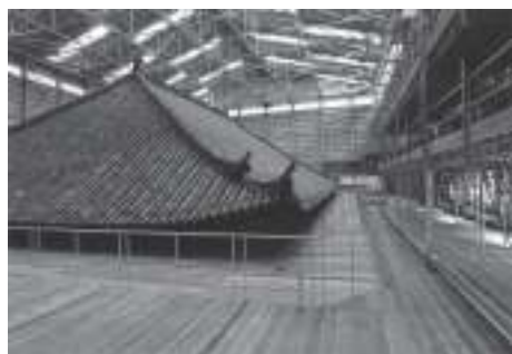
写真11 唐招提寺金堂素屋根内部
