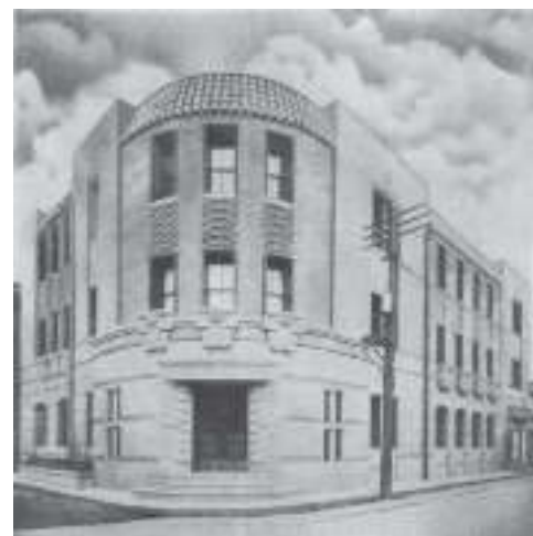
「建築と社会」1928（昭和3）年1月号より「芝川ビルディング」
