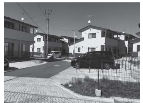
図1 住人が手を加えられない災害公営住宅は疎外感を感じさせる
