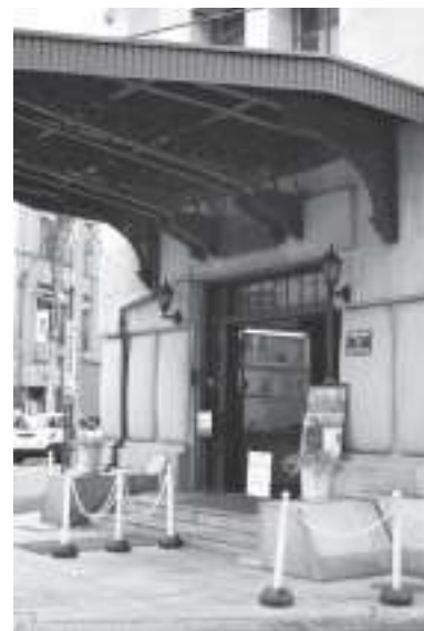
⑤正面玄関と大底には個性的な意匠が光る。底はチャンネル鋼材をラチスに組んだ構造で、ブロンズの凝ったブラケットで支持されている。
