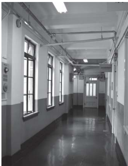
⑥ 3階廊下、左側窓は屋上光庭に面している。
