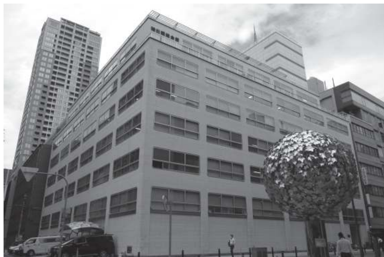
①南西から見る（現状／筆者撮影）
