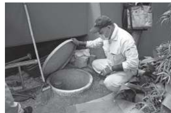
⑬マンホールを開けたところ
