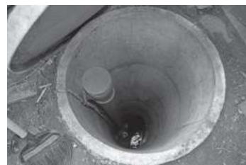
⑮マンホールの底の排水の様子
