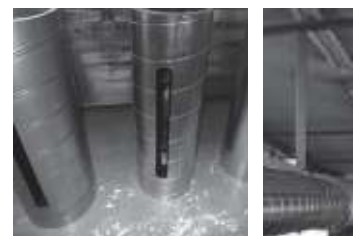
モックアップ、耐震吊り
