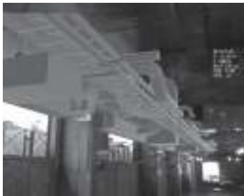
施工モデルの現地投影
