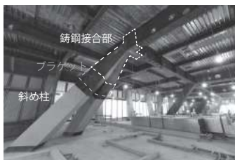
図7 鋳鋼接合部の施工時写真
