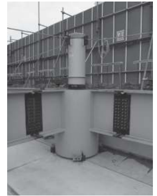
写真2 竹中コンパクトパイルキャップ®
