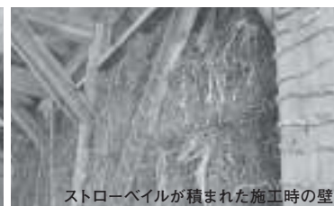
ストローベイルが積まれた施工時の壁
