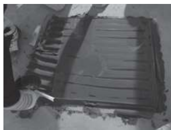
写真2 ガラスを用いたMO充填確認
