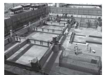
写真4 基礎工事状況
