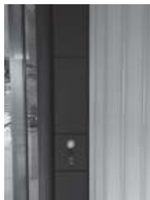
写真2 スイッチ設置部 （扉全閉）
