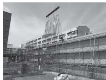
地組み鉄筋吊り込み
