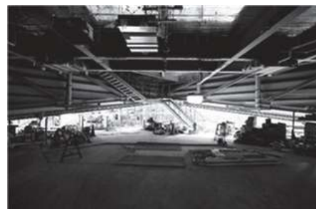
図5 施工時内観写真(ジャッキダウン後)
