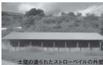
土壁の塗られたストローベイルの外壁
