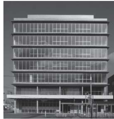
写真1 建物全景写真
