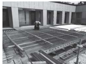
鉄筋地組み
