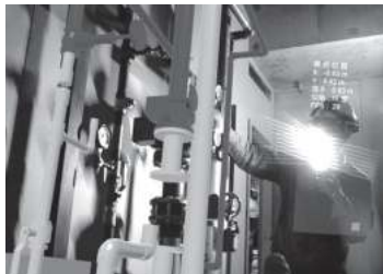
水圧試験実施箇所を現地で見える化
