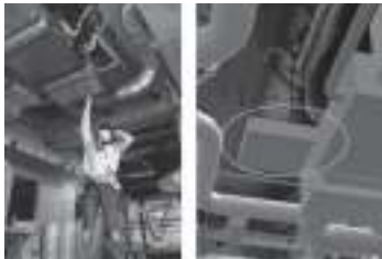
実施状況 モデル投影状況 天井点検口位置確認
