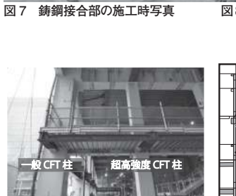
図10 超高強度CFT柱(600mm角)と一般CFT柱(1000mm角)
