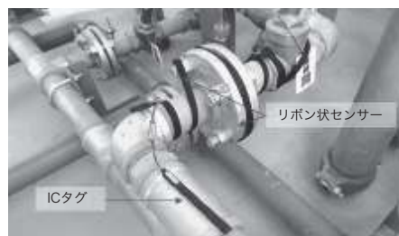
図4 配管接続部に設置した事例
