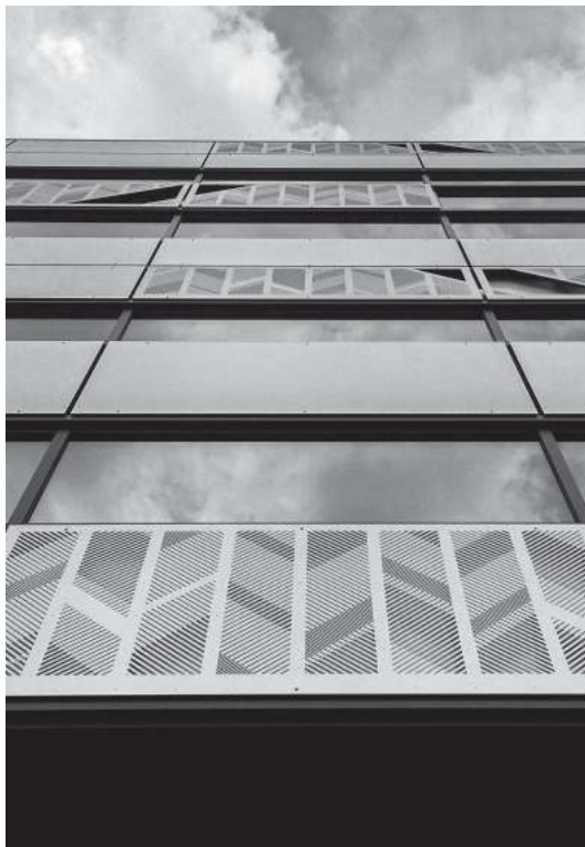
大阪国際空港 滑走路側外壁
