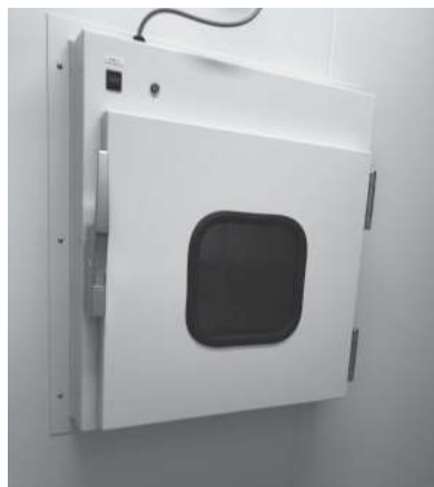
図2 加工室内へ資材を搬入するためのパスボックス
